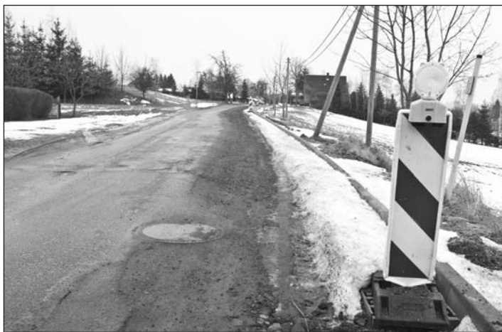
Die Tiefbau-Maßnahmen in unserer Gemeinde, wie hier die Röllingshainer Straße, ruhen wegen des Winters.
